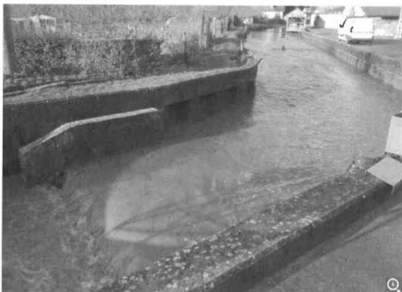
Le débit a permis d'ouvrir le clapet à Chouzy-sur-Cisse, transformant le canal de Hollande en cours d'eau rapide ! (Photos SMB Cisse)
