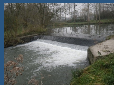
Déversoir du moulin de Goubert
