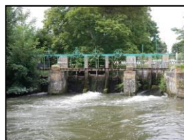
Exemple de vannage présents sur le bassin de la Cisse
