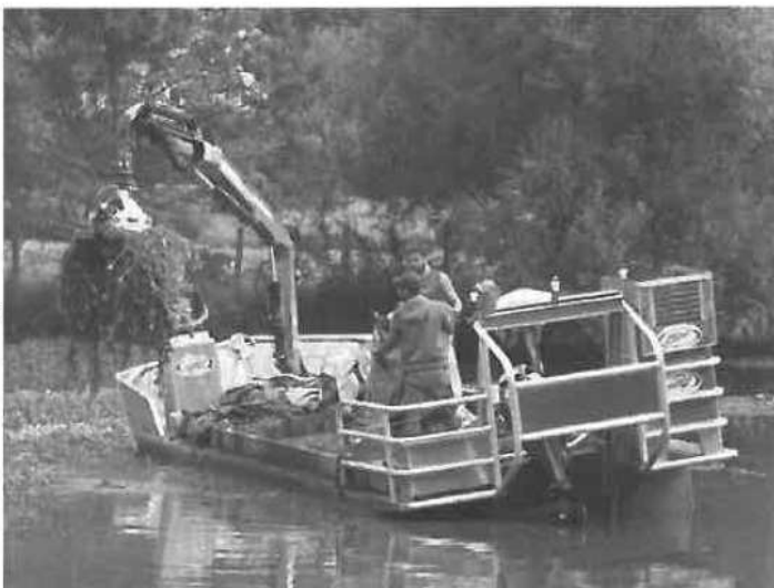
Une barge a été spécialement conçue pour optimiser l'arrachage de la jussie, avec un évident succès.
